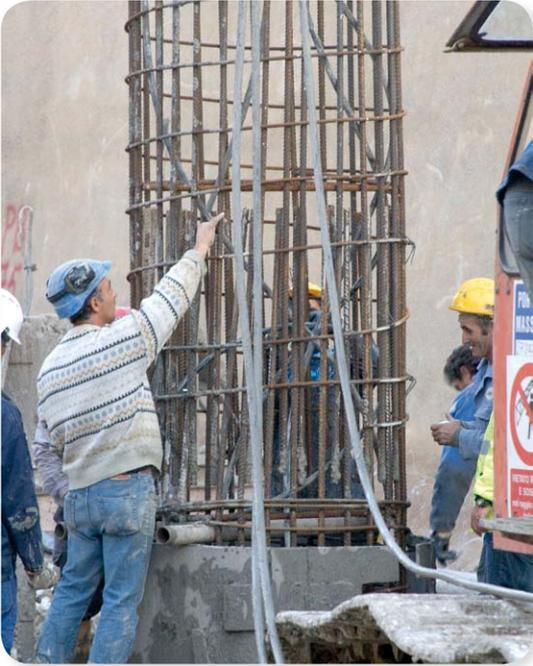
L'impianto geotermico dell'Università di Roma 3 rappresenta la più grande installazione a livello Europeo che sfrutta l'energia geotermica mediante pali di fondazione.
